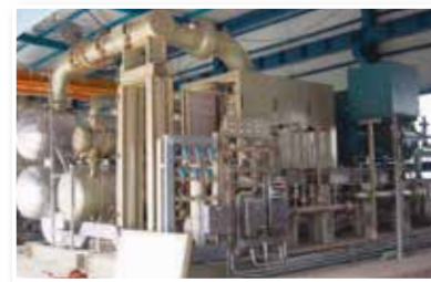
LNG BOG compressor - Turkey 400S / 830kW
